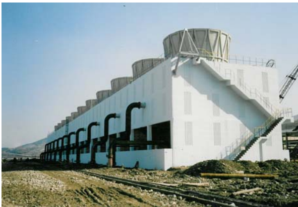
[그림 10] 대향류형 냉각탑(Counter Flow Tower)과 단면도
