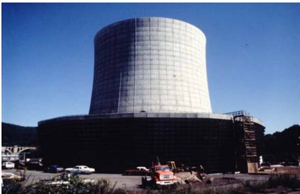
[그림 7] 조합식 냉각탑(Hybrid Draft Tower)와 단면도 팬보조자연통풍식 냉각탑(Fan Assisted Natural Draft Tower)
