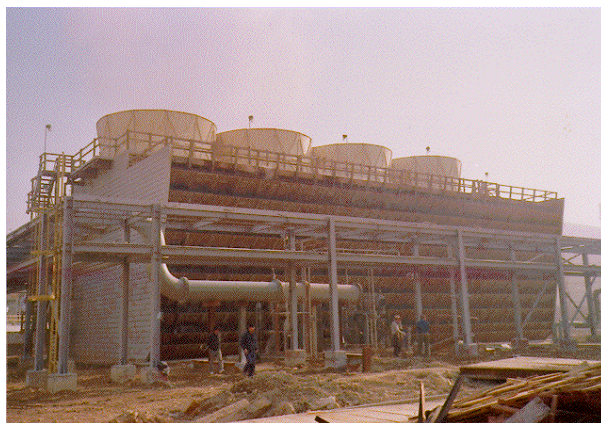
[그림 8] 흡입식 냉각탑(Induced Draft Tower), 직교류형 냉각탑(Cross Flow Tower)
